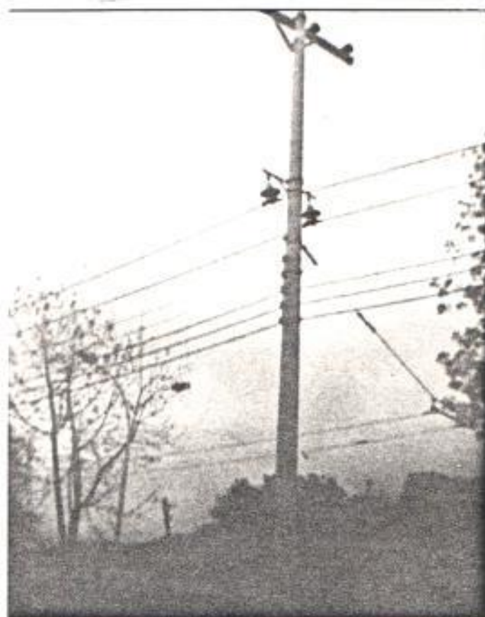
FIGURA No. 4.32 POSTE MULTIUSO
