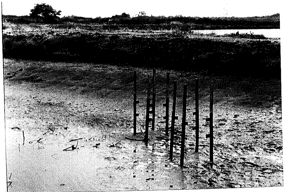
ESTACAS DE MANGLE CON TACOS
