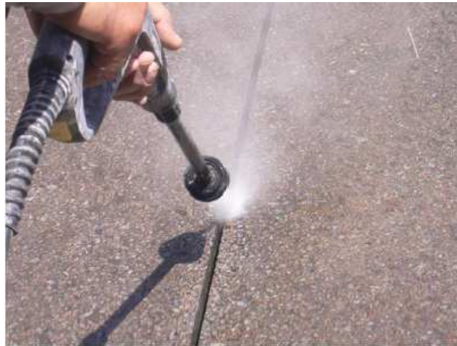
Fig. 4.17 Limpieza de la microzanja
