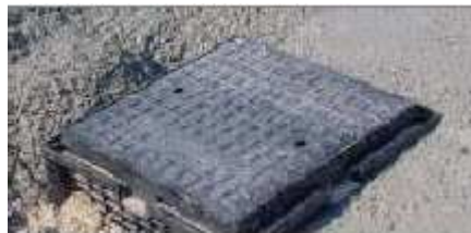
Fig. 4.23 Tapa de Fundición de arquetas
