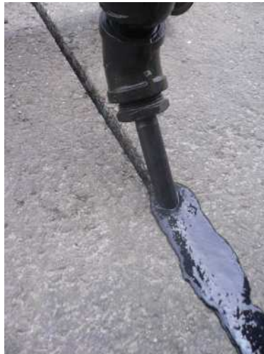
Fig. 4.20 sellado de la microzanja con asfalto líquido
