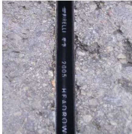
Fig. 4.19 Cable de fibras en la microzanja
