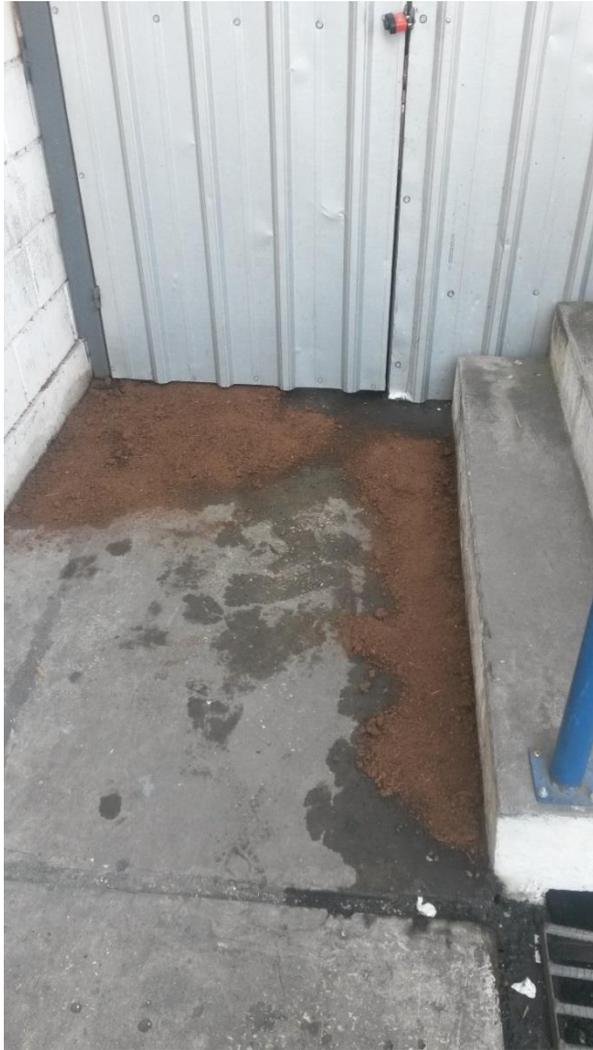
Control en la fuente del factor de riesgo. Piso mojado recubierto de aserrín para evitar resbalones y caídas al mismo nivel. (área de Repuestos y Accesorios).
