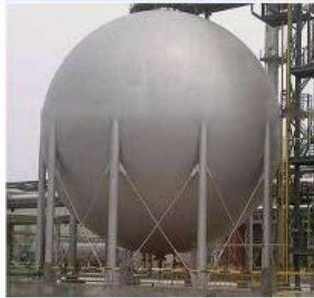
Figura 1.3. Cámara de contención esférica
