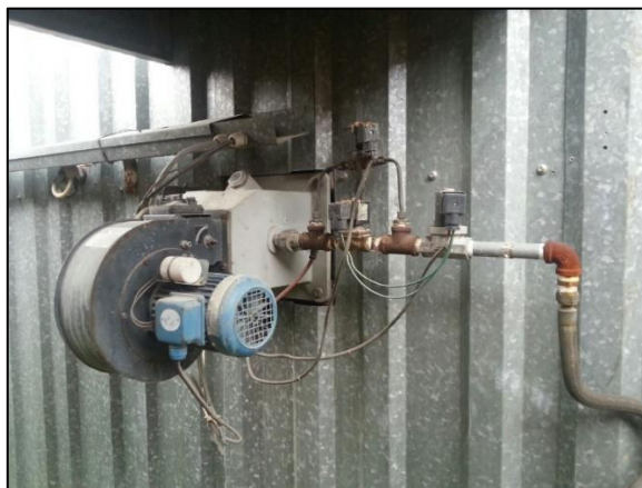
Figura 1.5 Configuración para la Combustión de GLP
