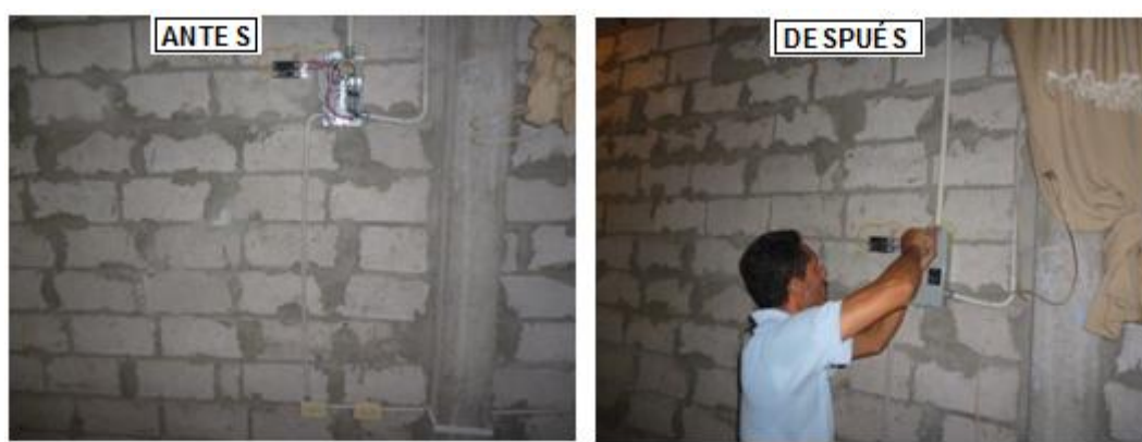
Figura 3. 57: Instalación de caja de breaker y tomacorrientes
