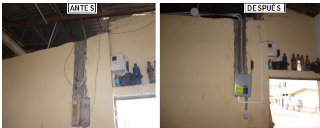
Figura 3. 40: Instalación de caja de breakers
