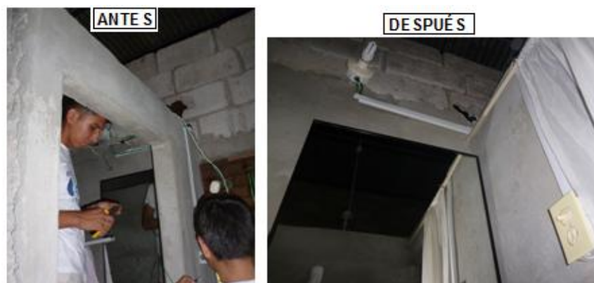
Figura 3. 36: Instalación de interruptor mixto en baño
