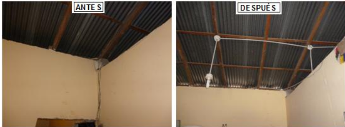
Figura 3. 42: Instalación de luminarias a través de tuberías
