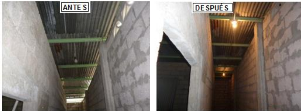
Figura 3. 55: Instalación de iluminarias en corredor
