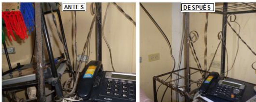
Figura 3. 43: Instalación de tomacorrientes en cajas rectangulares
