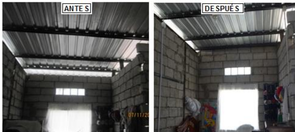
Figura 3. 30: Instalación de iluminarias en dormitorio
