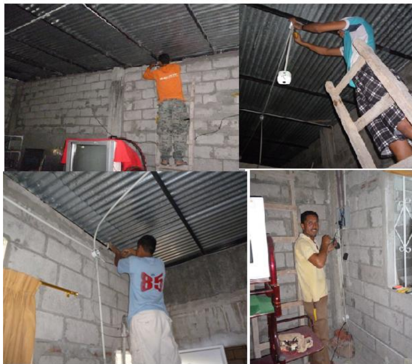
Figura 3. 37: Collage arreglo instalaciones eléctricas
