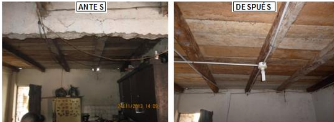
Figura 3. 52: Instalación de iluminaria en la cocina
