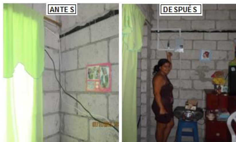
Figura 3. 29: Instalación de panel de breakers
