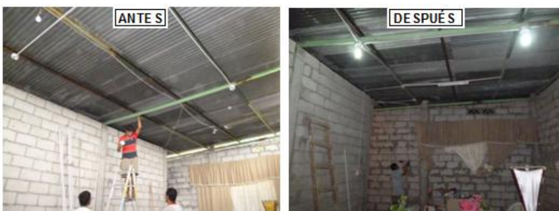
Figura 3. 54: Instalación de iluminarias
