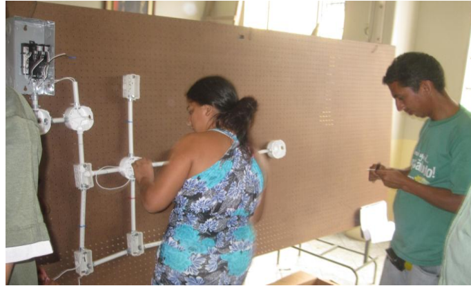
Figura 3. 11: Conexión en paralelo tomacorrientes de 120V
