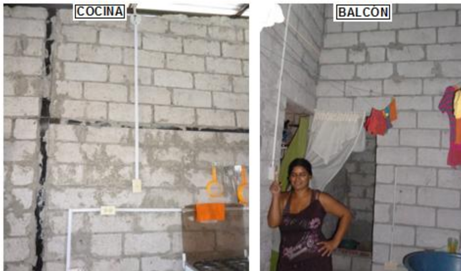
Figura 3. 32: Culminación de instalaciones eléctricas
