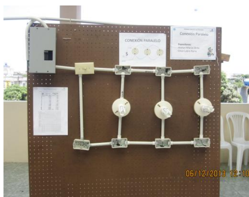
Tomadas por: Luis De La Torre - Gino Cárdenas
