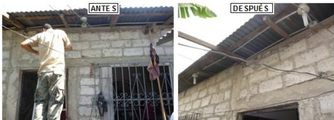
Figura 3. 45: Instalación de luminarias en patio
