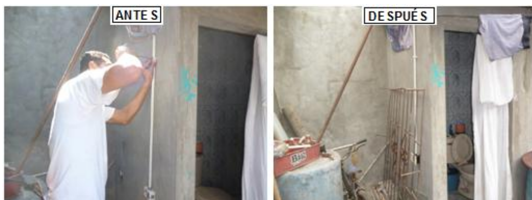
Figura 3. 46: Instalación de tomacorriente 120V para lavadora
