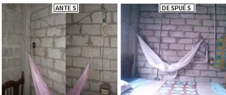
Figura 3. 34: Instalación de tomacorriente y reubicación de breaker
