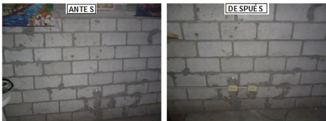
Figura 3. 56: Instalación de tomacorrientes de 120V
