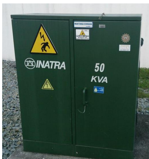
Figura 1. 14: Transformador trifásico Padmounted
