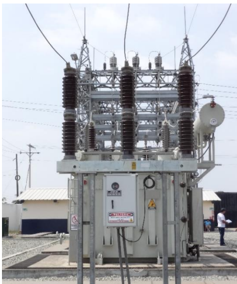
Figura 1. 7: Disyuntor en SF6 de 69 KV
