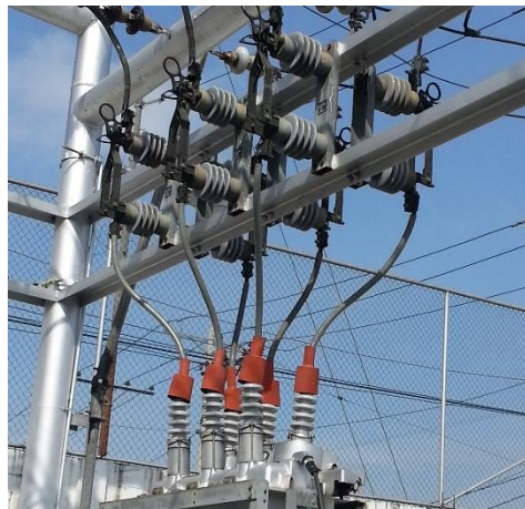
Figura 1.11 Cuchillas seccionadoras 600 [A].
