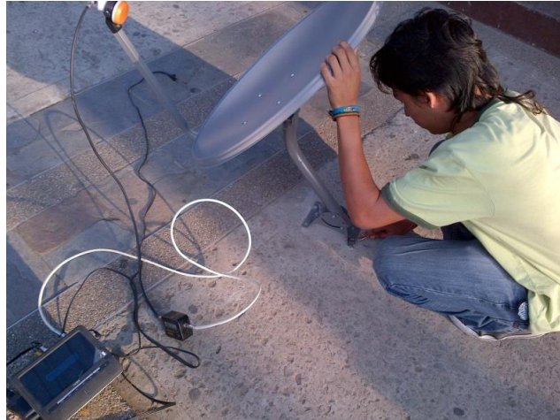
Figura A.11 Terminando de Ajustar Fijamente la Antena al Suelo después de Encontrar la Señal.
