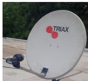
Figura 2.2 Antena Offset.
