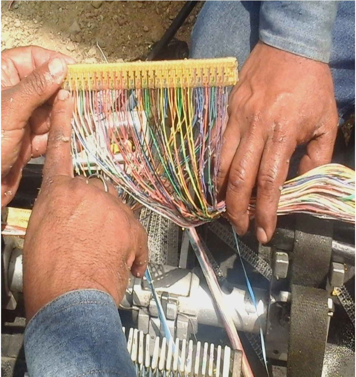
Fig. 5.25 Empalmado del Cable de 50
