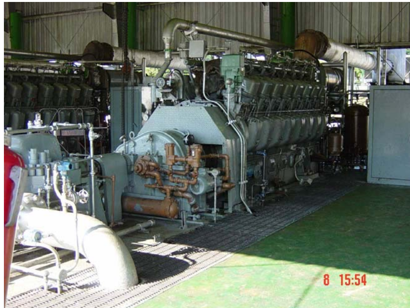
Unidad de Bombeo
