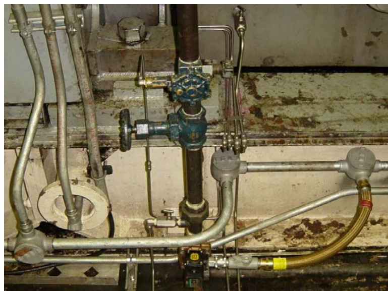
Válvula Solenoide de Aire
