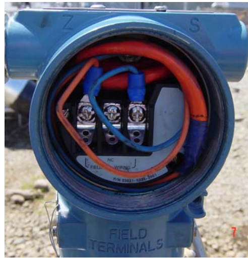
Conexión Transmisor de Presión
