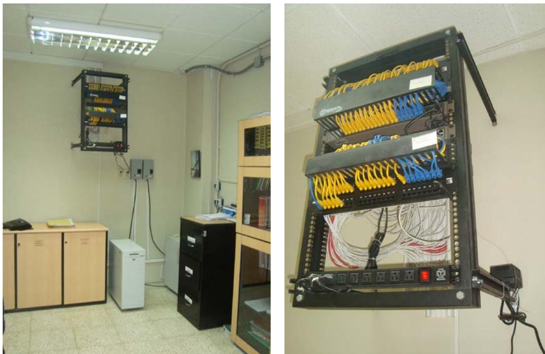
**Figura 4.1:** Laboratorio del CEN, mostrando *Rack* con *switches*, UPSs y acometidas eléctricas
