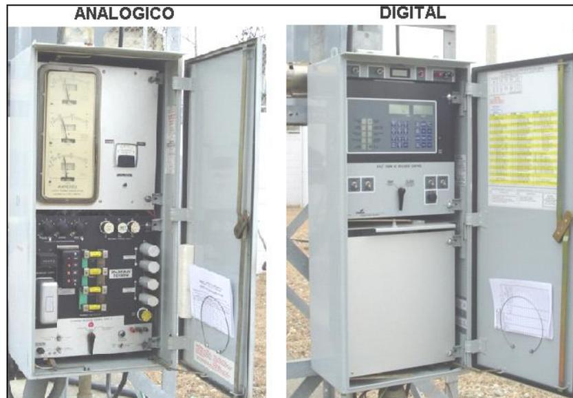
**Fig. 4.10 Gabinetes de control de los Reconfiguradores**
