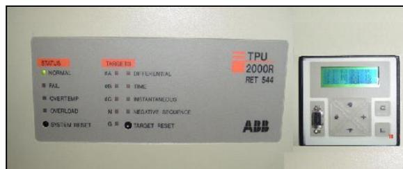
**Fig. 4.16 Dispositivo Electrónico Inteligente de Protección**
