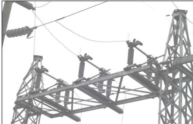
**Figura 4.3 Seccionador de aire con cuchillas de tierra**
