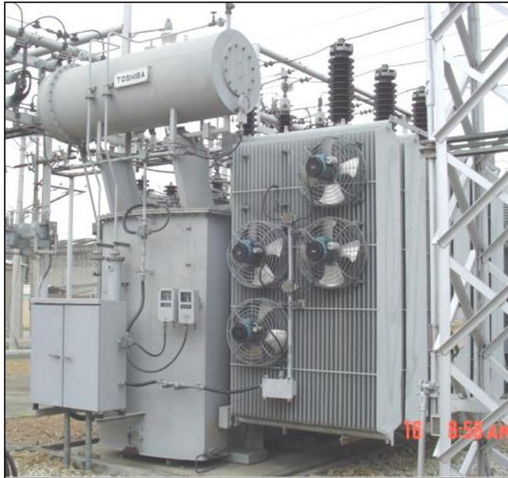
**Fig. 4.6 Transformador de poder marca TOSHIBA 67/13.8Y KV**
