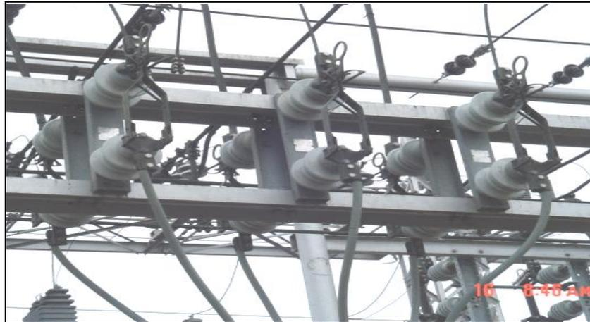
**Fig. 4.11 Cuchillas Seccionadoras de Alimentadoras**
