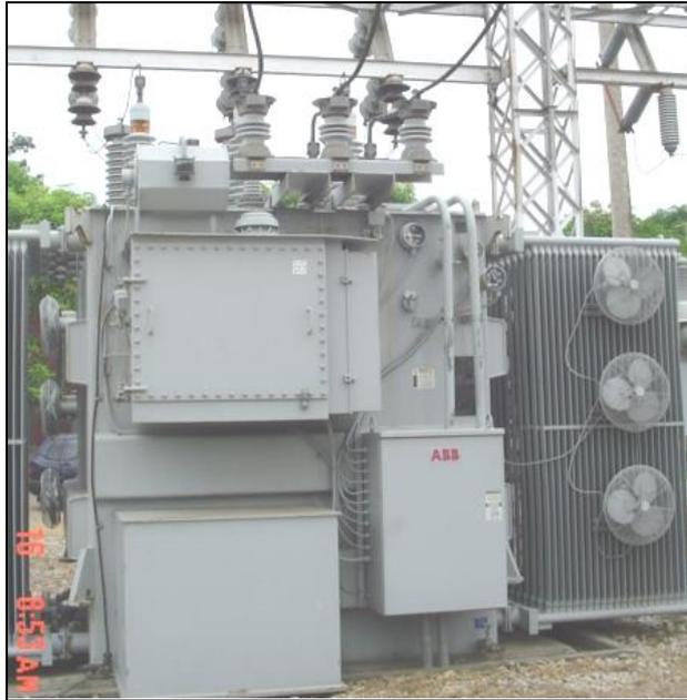
**Fig. Pararrayos sobre Transformador en lado de Baja Tensión**
