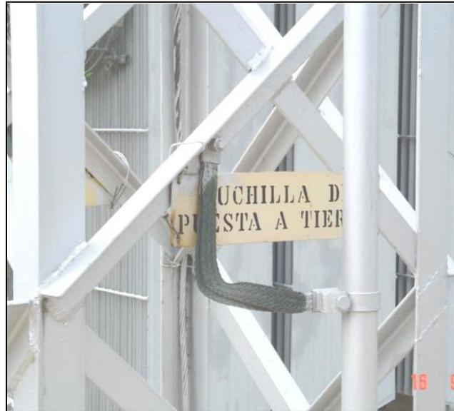
**Fig. Puesta a Tierra de Estructuras de la Subestación**
