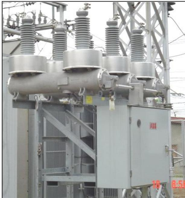
**Fig. 4.5 Interruptor en gas SF6 (GCB) de Mapasingue 1**
