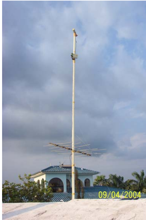
Fig. 2.34 Instalación de torre de prueba para transmisión.
