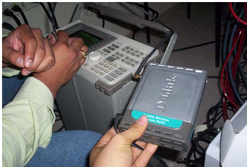
Fig. 2.30 Medición de potencia irradiada por el equipo DWL-700AP D-Link.
