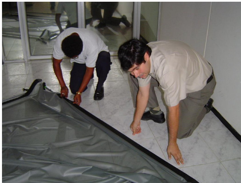
Figura 4-26 Montaje de la pantalla de proyección
