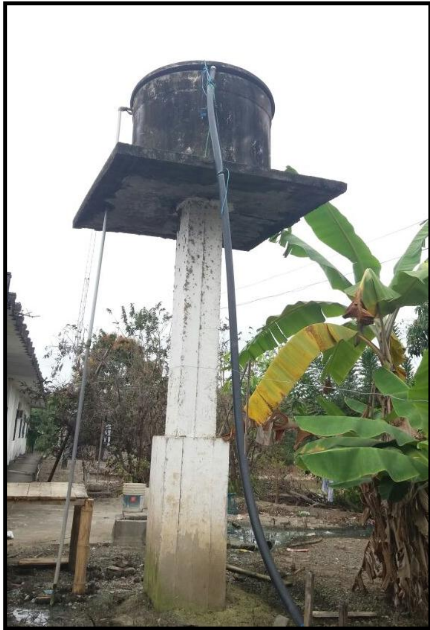
Figura 1.1.2. Tanque elevado con manguera haciendo sifón
