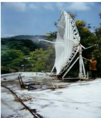
Figura 4-2 Limpieza y mantenimiento de la superficie reflectora
