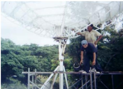
Figura 4-5 La antena de la FIEC quedó embancada para colocar los nuevos elementos para posicionamiento.
