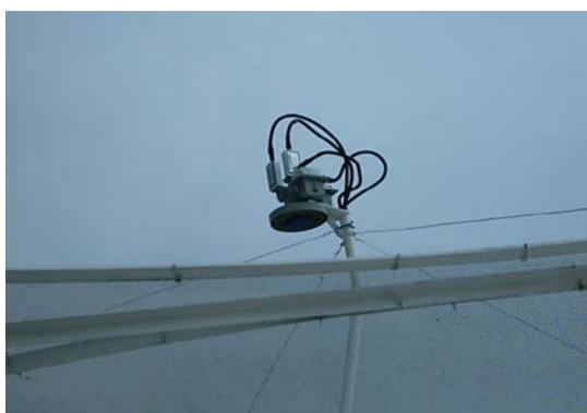
Figura 4-10 Alimentador (feeder) de cuatro bocas para recepción en banda C V/H y Ku V/H, ya instalado en la antena
