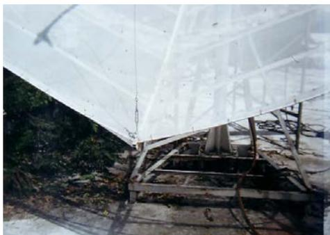
Figura 4-3 Uso de herrajes para asegurar el foco del paraboloide
