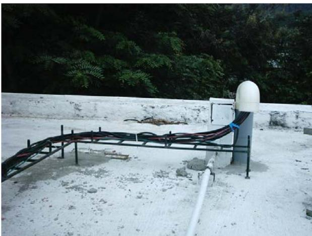
Figura 4-8 Cableado de la estación en la terraza de los Laboratorios, nueva ductería y canaletas.
