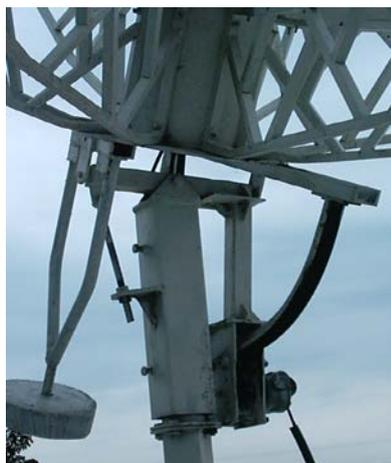
Figura 4-7 Contrapeso y Cremallera permiten que la estructura este balanceada y trabaje de manera segura
