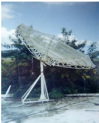
Figura 4-4 Retiro del brazo hidráulico de la anterior configuración para posicionamiento de la antena
