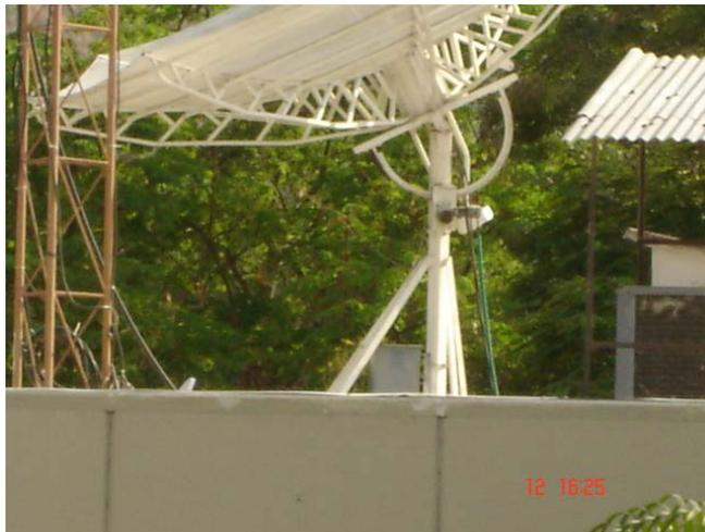
Figura 5-34 Caja de intemperie usada para guardar la interfase
