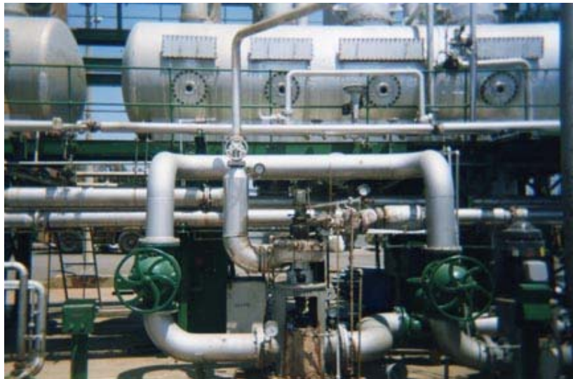
Foto 1: Vista de la planta actual
