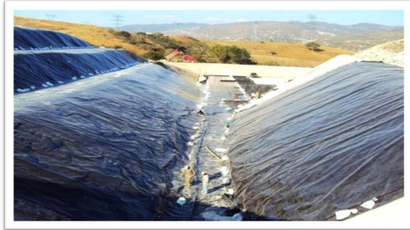
**Figura 2.** Geomembrana aplicada en un relleno sanitario.
