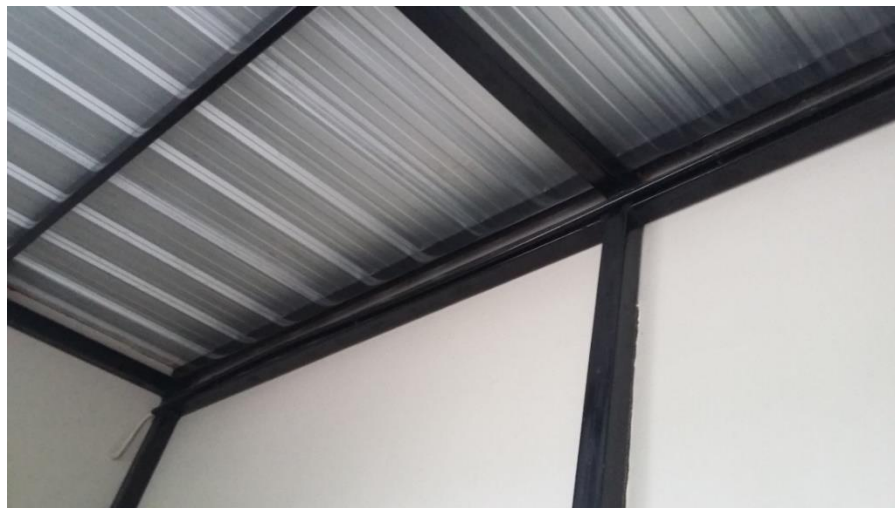
Figura 0.3 Estructura Existente de bodega. Fuente: Zamora, E., Landívar, M., 2017.
