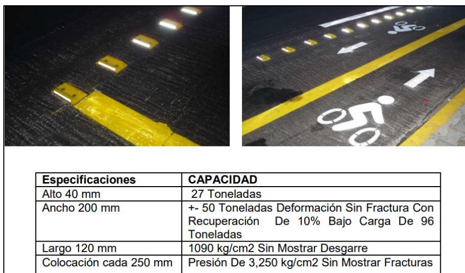
Figura 5.16 Separadores viales tipo tachones.
