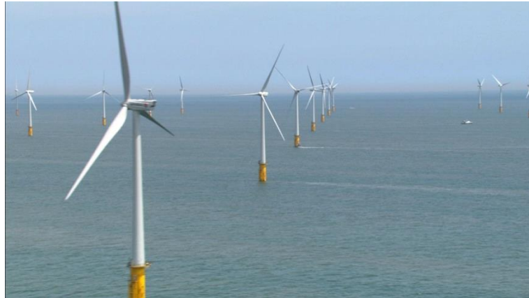
Figura 1.4 Thanet offshore, mayor parque eólico marino.
