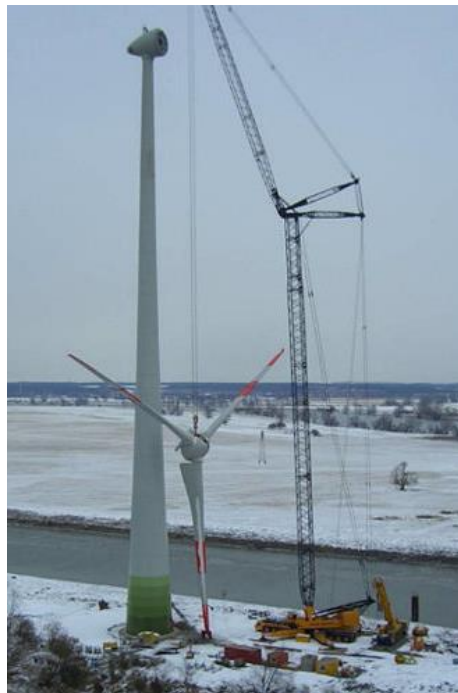
Figura 2.11 Instalación de una turbina Enercon. El empleo de grúas especiales es imprescindible.
