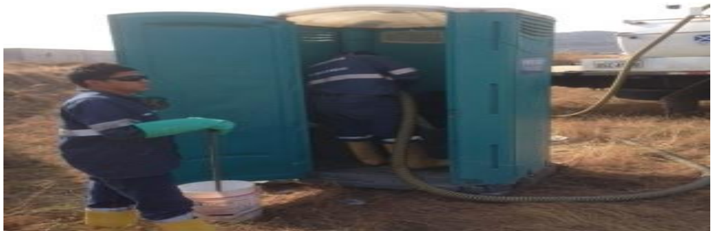
FIGURA 32: LIMPIEZA DE BATERIA SANITARIA.
