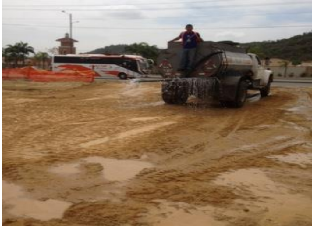
FIGURA 35: CONTROL DE POLVO CON TANQUEROS.
