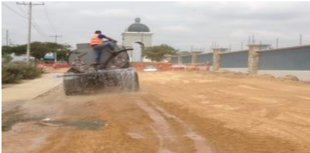
FIGURA 34: CONTROL DE POLVO CON TANQUEROS.
