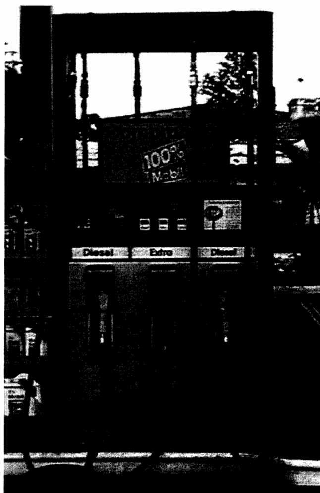
Figura 3.16: Dispensador de combustible MPD
