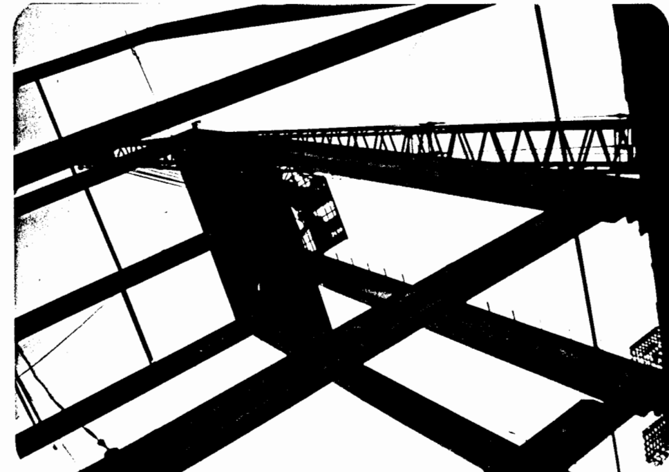
FIG. 3.19.- OPERACION DE SOLDADO DEL PLANCHAJE LATERAL DEL PRECIPITADOR ELECTROSTATICO DE LA LINEA 1 DE LA PLANTA "CERRO BLANCO". DERECHA: VISTA EXTERIOR IZQUIERDA: VISTA INTERIOR
