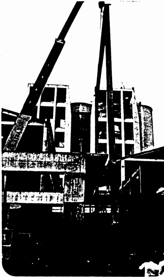
FIG. 3.16.- MONTAJE DEL PRIMER PORTICO DEL PRECIPITADOR ELECTROSTATICO.
