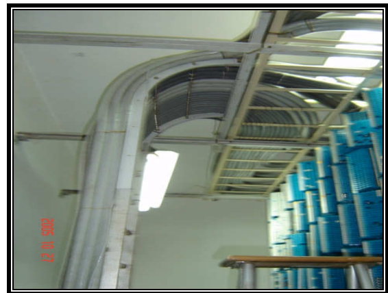
Figura 3.8 Canalizado de los cables hacia el switch de voz
