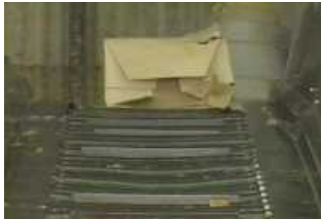
Fig 1.11 - Transportador de materias primas.
