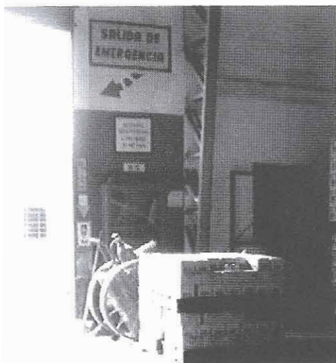
Fig. 3.11 Rótulos del sistema contra incendios
