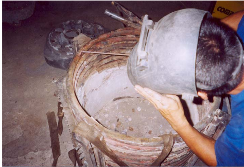
FIGURA 1.10 APLICANDO SOLDADURA DE BRONCE UTP-32 A LA BOBINA.
