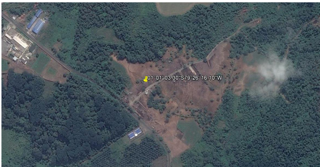
Figura 1.3: Estación Repetidora Ubicada en Quevedo
