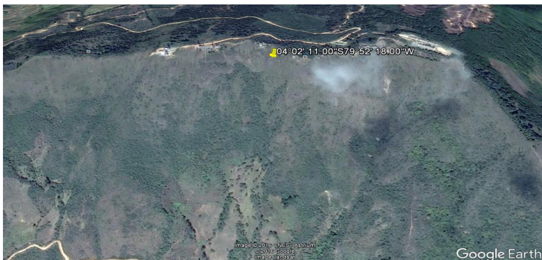
Figura 1.5: Estación Repetidora Ubicada en El Oro
