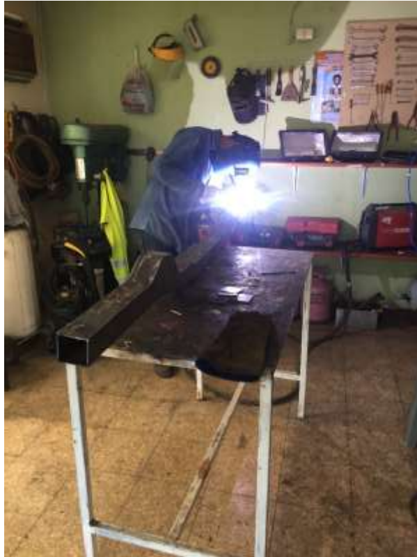
Figura 2.12 Soldadura de largueros con soldadura TIG
