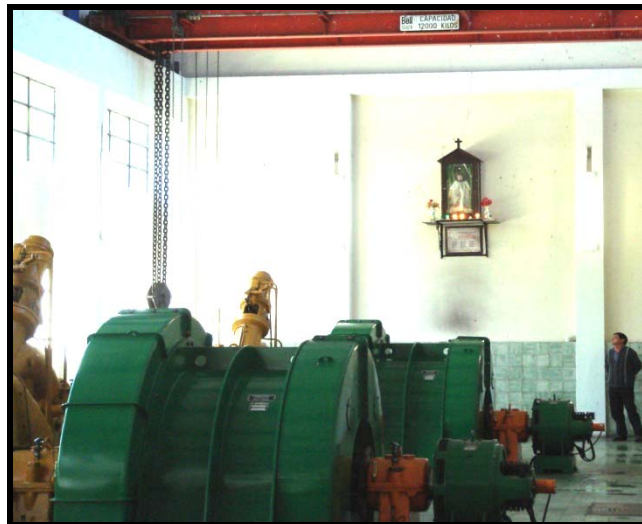
FIGURA 1.5 CASA DE MAQUINAS
