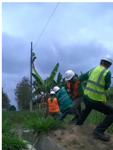
Figura 1.2 Instalación de cable de fibra óptica
