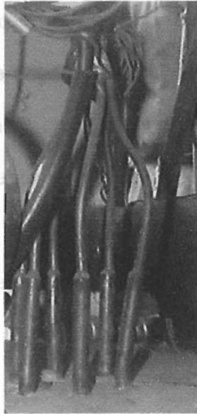
FIGURA 2.6. DISTRIBUIDOR DEL EVAPORADOR DEL CHILLER
