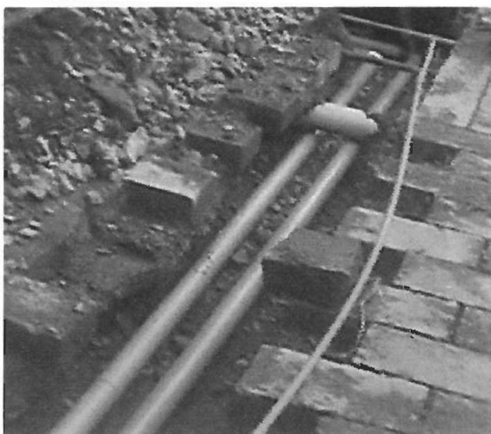
FIGURA 3.6. TUBERÍA AISLADA ENTERRADA
