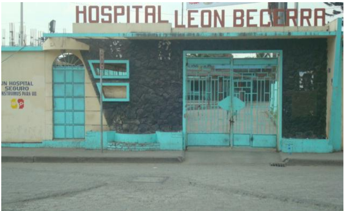
Figura A.1-1 Entrada principal del hospital
