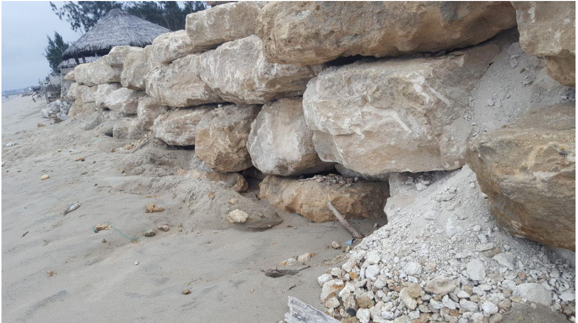
Imagen 1. Estructuras de protección construidos en el borde de las casas de Pacoa.
