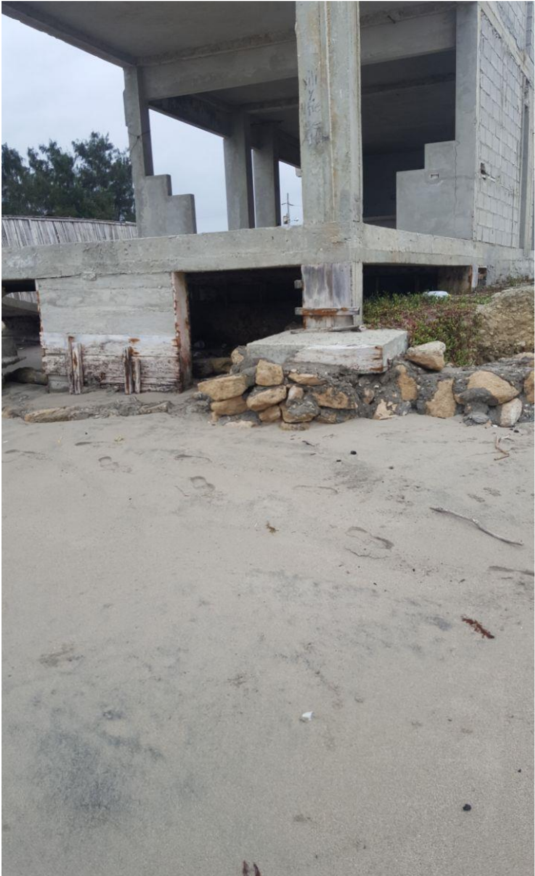
Imagen 7. Casa en proceso de construcción.
