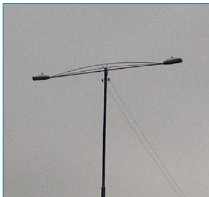
Figura 5.7 Luminaria de vapor de sodio de alta presión de 400 W.
