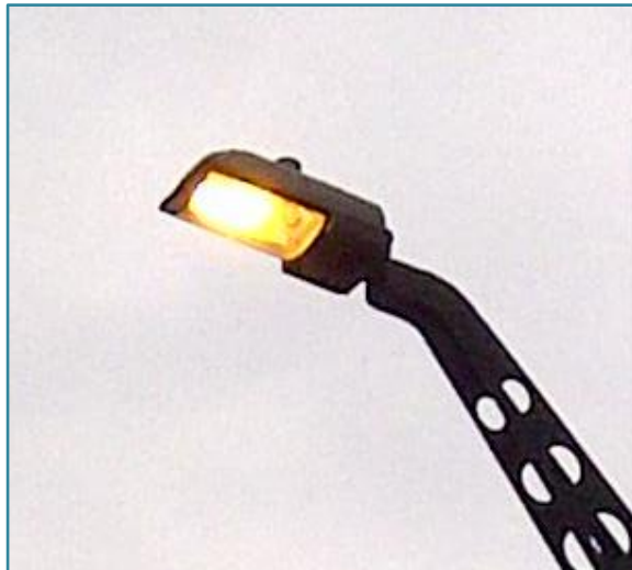
Figura 5.2 Luminaria de vapor de sodio de alta presión de 250 W.
