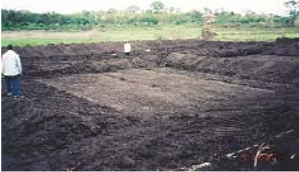
Módulo de cultivo recién construido
