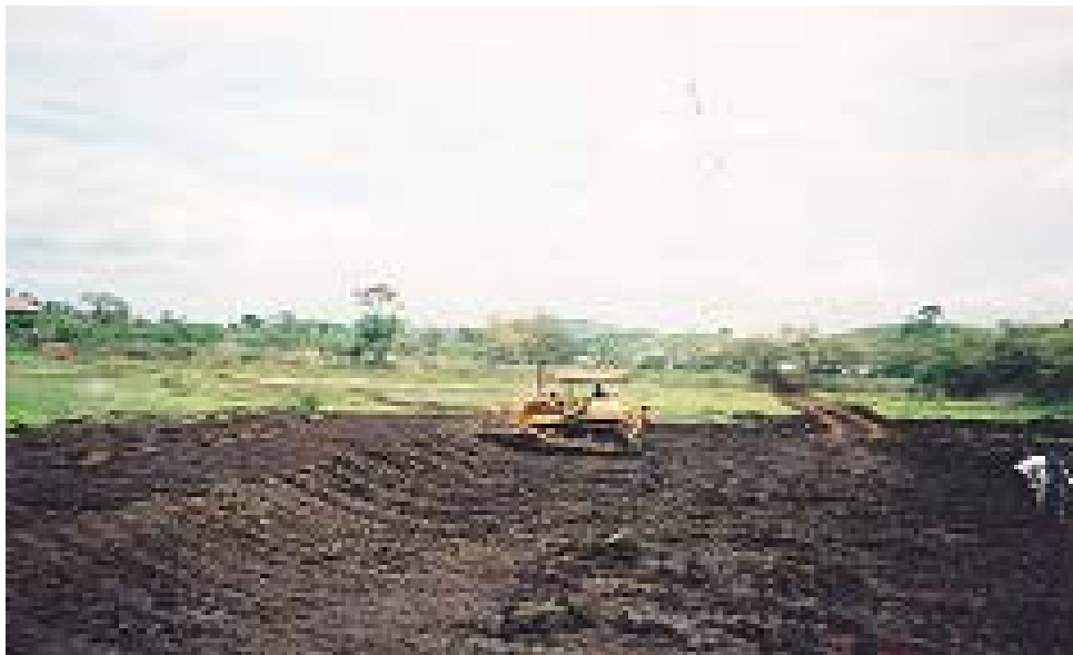
Construcción de muros perimetrales y canal de drenaje
