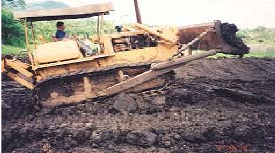
Movimiento de tierra y construcción de muros perimetrales
