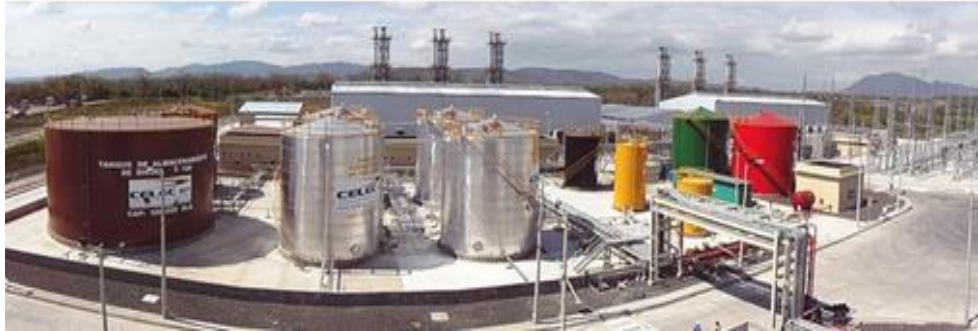
Figura 1.2 Vista de la Central Termoeléctrica Jaramijó
