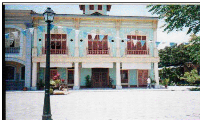
FOTO 20: ZONA URBANO-ARQUITECTONICA-PARQUE HISTORICO
