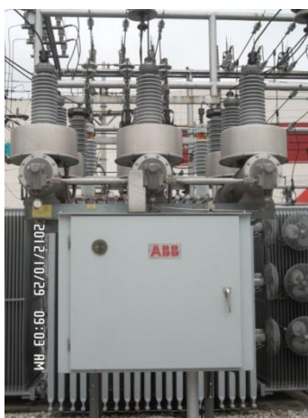
Figura 1.2 Unidad de Medición de Tensión y Corriente
