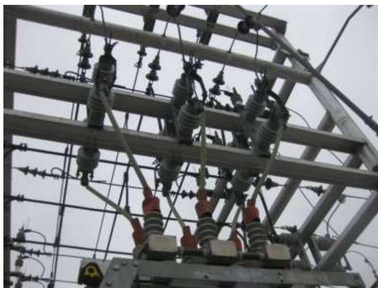
Figura 1.10 Cuchillas seccionadoras 600 A.
