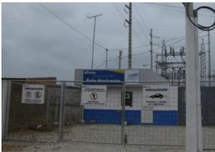
Figura 1.2 Vista exterior de la Subestación Belo Horizonte.
