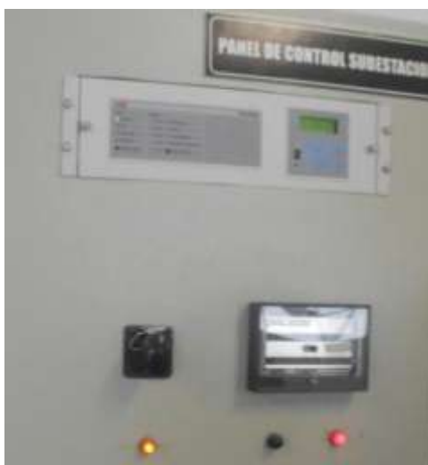
Figura 1.14 Panel de control con el relé TPU2000R.
