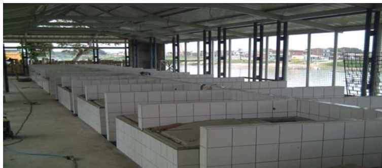
Foto 16.- Nuevas instalaciones del mercado de mariscos de Babahoyo
