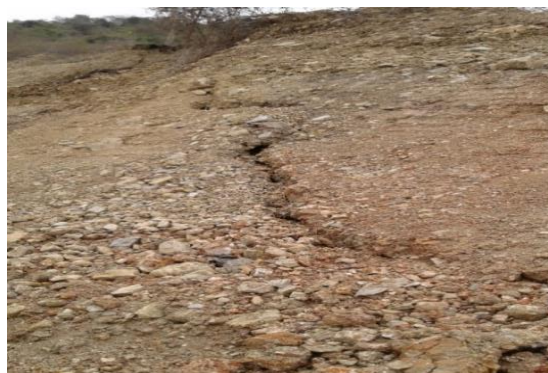
Figura 3. 3 Fisura del segundo talud. Fuente: Suárez, C., Vicuña, B.,2018.
