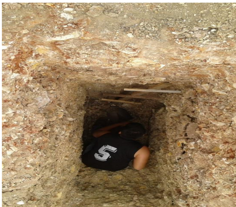
Figura 3. 7 Inspección técnica y toma de Materiales. Fuente: Suárez, C., Vicuña, B.,2018.
