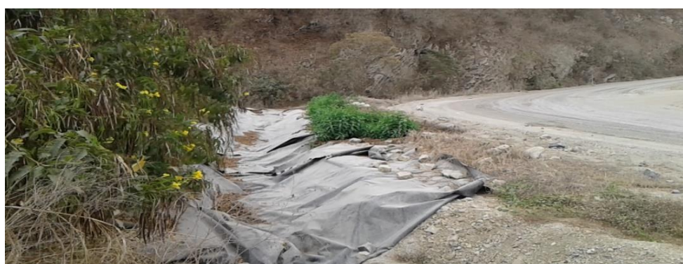
Figura 3. 6 Canal con geomembranas que controla los flujos aguas arriba.
