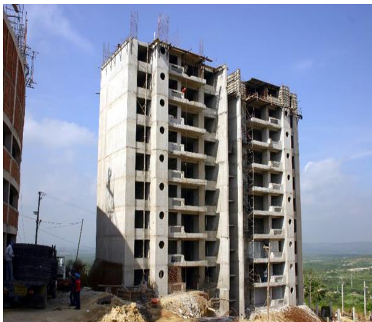
Figura 4. 6 Edificio con muros de corte o diafragmas. Fuente: “Sistemas estructurales Blog 360 en concreto, Argos.
