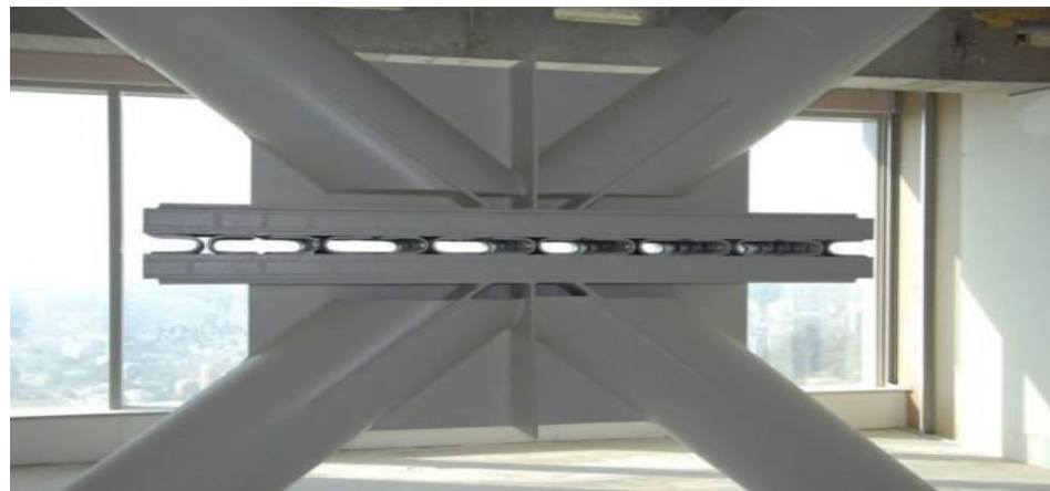
Figura 4. 3 Control pasivo de estructuras. Fuente: Universidad de Santiago de Chile, Diseño Civiles,2017.
