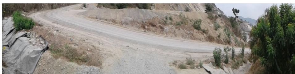
Figura 3. 5 Vía del acceso a la cantera con su respectivo canal.
