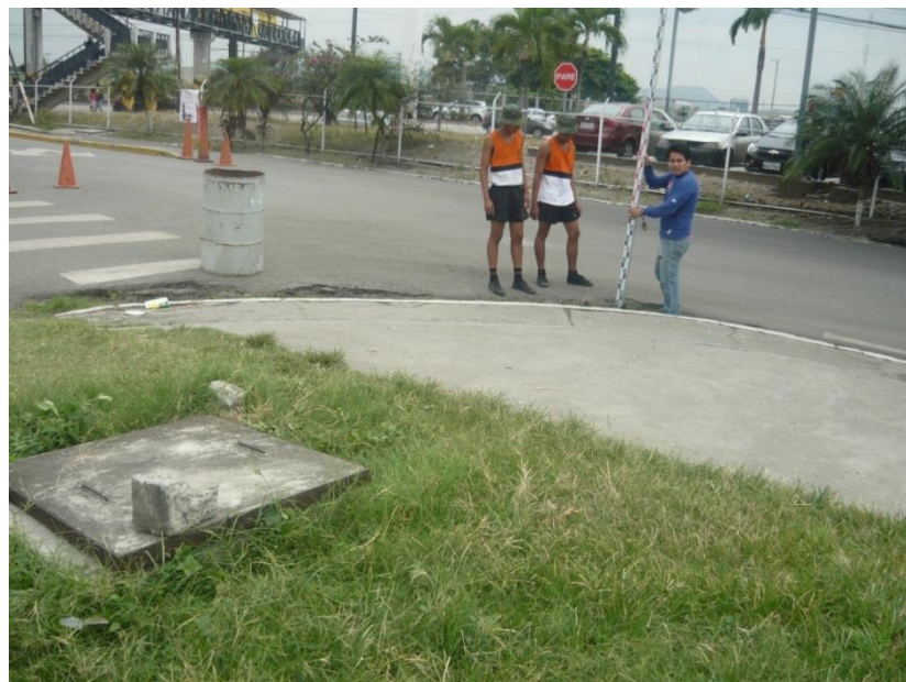
Figura 11.6 Medición de cotas de las cámaras y sumideros
