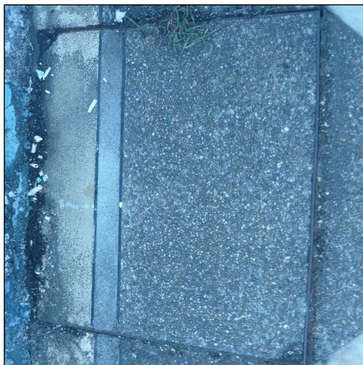
Figura 11.27 Filos de caja unidos con el nivel del piso
