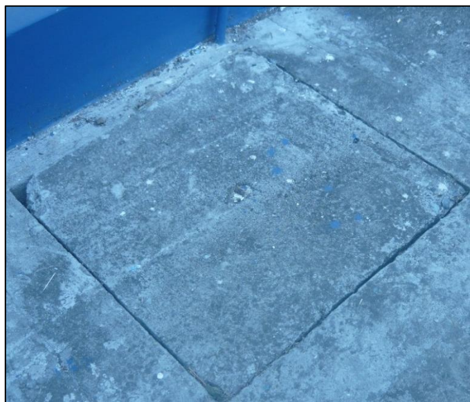
Figura 11.46 Tapa da caja al mismo nivel del piso
