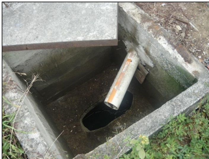
Figura 11.18 Caja de registro de la línea de AALL
