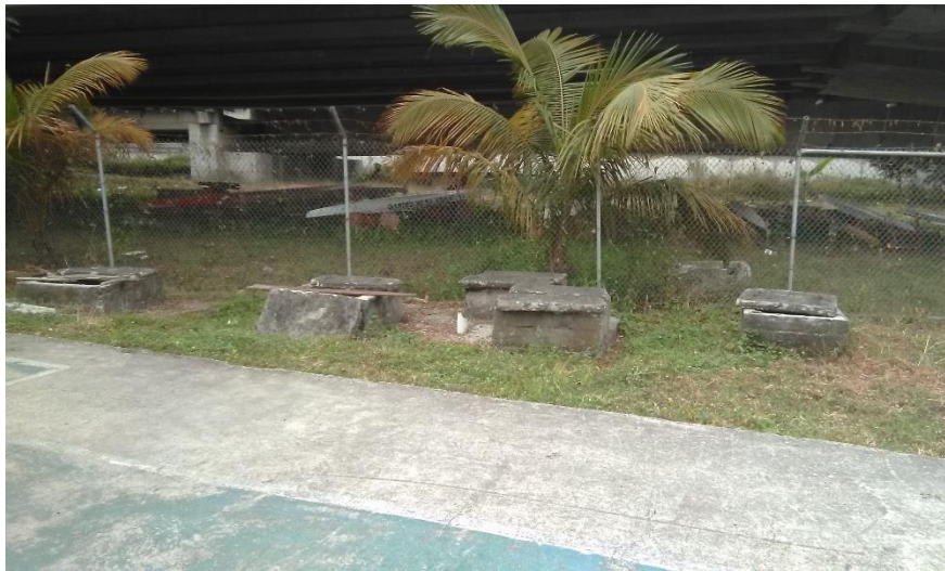
Figura 11.12 Pozos cerca del puente
