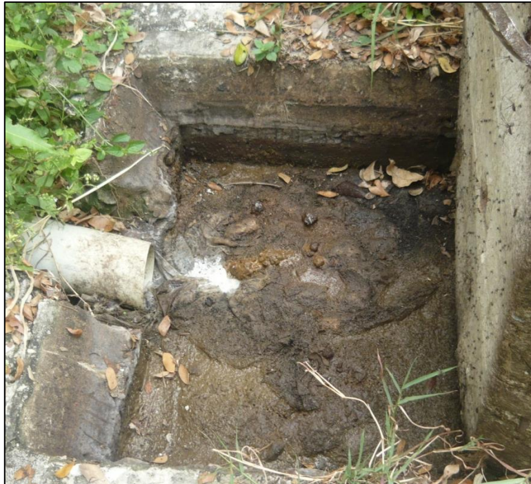
Figura 11.23 Caja de registro al límite de su capacidad
