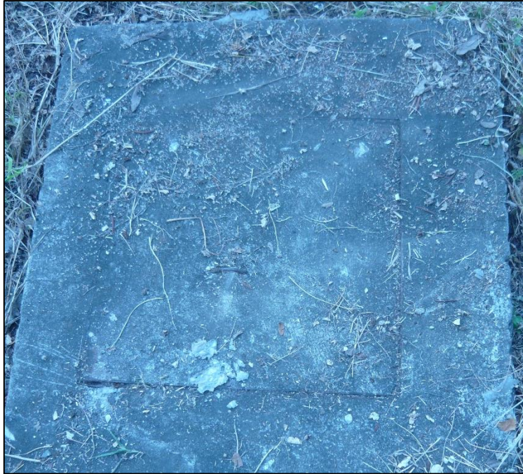
Figura 11.34 Caja sellada, difícil de abrir para observación.
