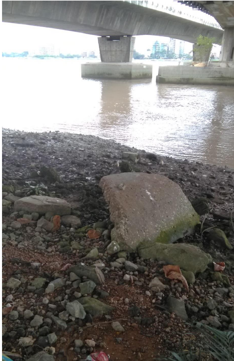
Figura 11.14 Restos de hormigón cerca de la ubicación de las cámaras.
