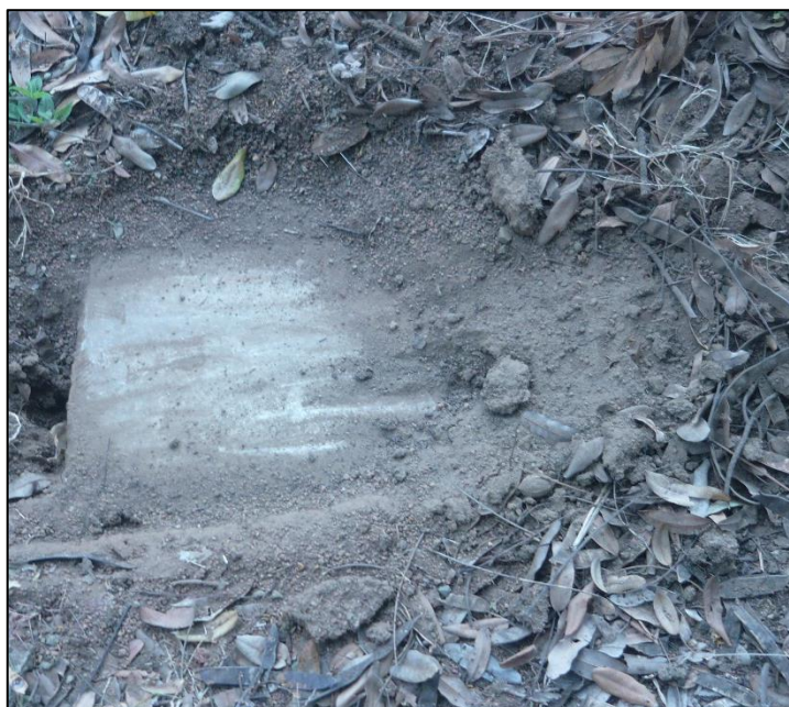
Figura 11.31 Superficie de la caja cubierta por tierra. Caja escondida
