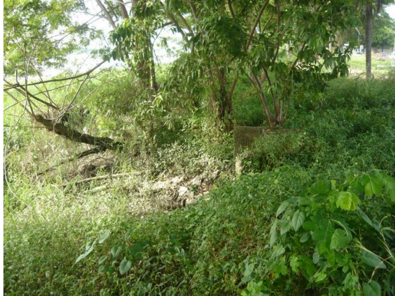
Figura 11.3 Salida de aguas lluvias
