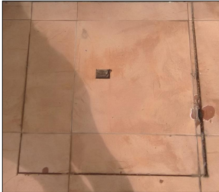
Figura 11.21 Tapa cubierta por baldosa
