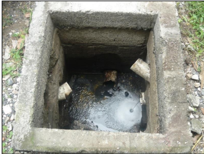
Figura 11.17 Línea de AALL caja de registro
