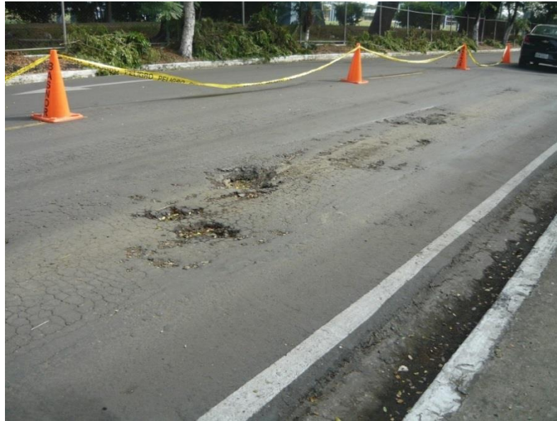
Figura 11.5 Carpeta de asfalto cubriendo cámara de revisión de AALL
