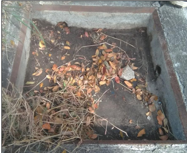
Figura 11.20 Caja sellada por una capa de hormigón
