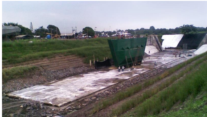
Figura N°1.2.- Dique Seco del Astillero ASENABRA S.A.
