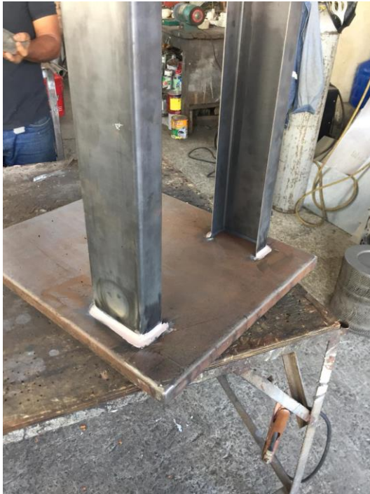
Figura C7. Soldadura de los parantes en la base
