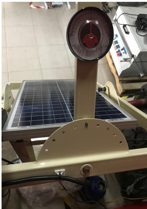
Figura C18. Instalación de juntas plásticas para la distribución del cable eléctrico
