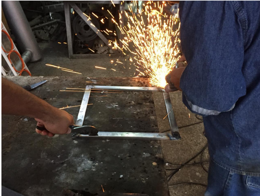
Figura C3. Remoción de excesos de soldadura con pulidora
