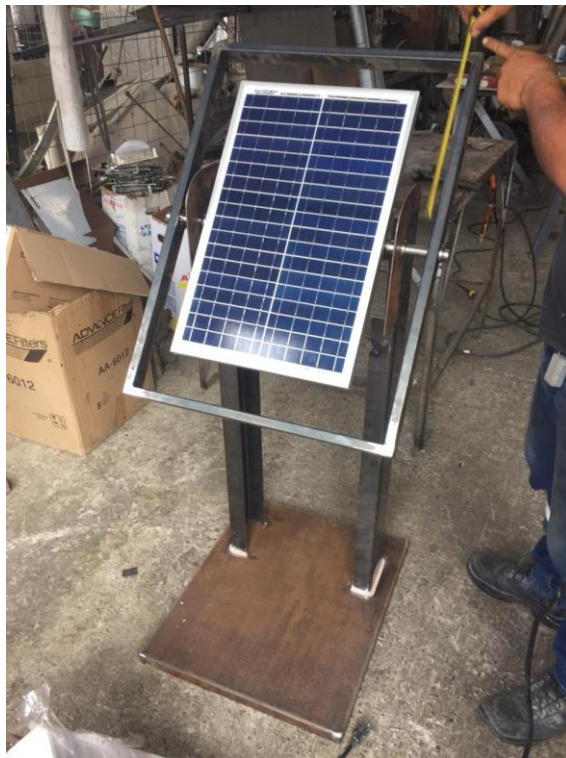
Figura C10. Colocación del panel y verificación de las medidas.
