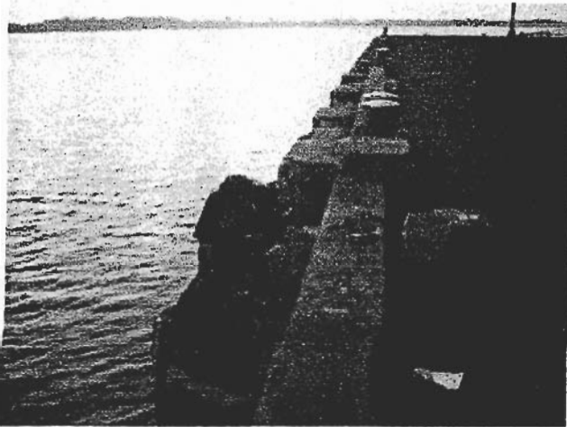
FOTOGRAFÍA 1. TOMA DE POTENCIAL NATURAL, PANTALLA No. 20, LADO SUR, COTA + 4.300 MSNR, CARA SUPERIOR
