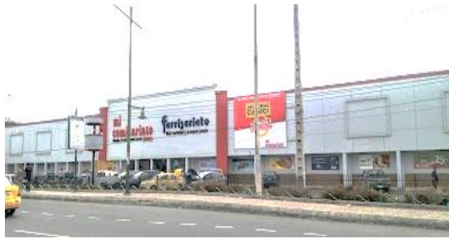
Figura 3. 6 Mi Comisariato Ubicado en la Avenida Nicolas Lapentti- Durán Fuente: Google Maps, Inc.
